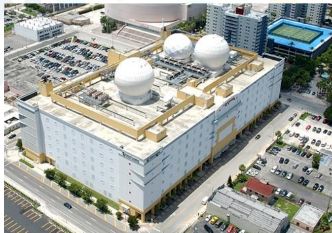
Figura 72. Datacenter del NAP de las Américas en Florida (USA).
